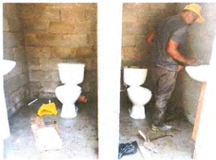
Foto 11: Letrina sustituido por baño cerámico.
