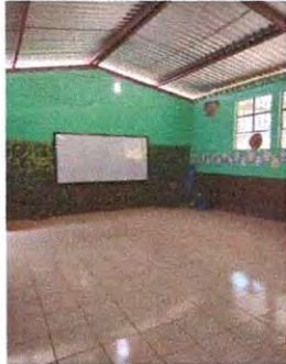
Foto7: Sustitución de piso de torta por piso cerámico aula dede segundo
