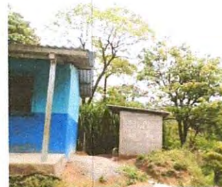
Foto 12: Pared de baño de lámina sustituido por block.
