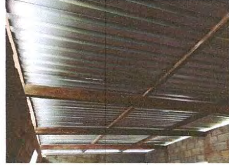
Foto 14: Cubierta de lámina de bodega sustituido.
