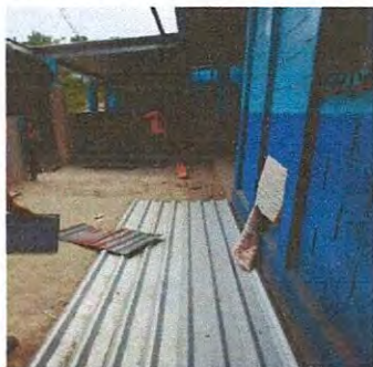
Foto 13: Cubierta de lámina de patio en mal estado.
