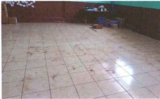
Foto 9: Sustitución de piso de torta por piso cerámico aula de primero
