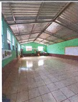
Foto 5: Sustrucción de piso de torta por piso cerámico aula de Sexto
