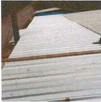
Foto 13: Cubierta de lámina de patio sustituido.
