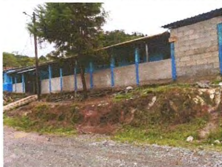
Foto 1: Sustrucción de un metro malla por muro perimetral de la parte frontal del centro educativo.
